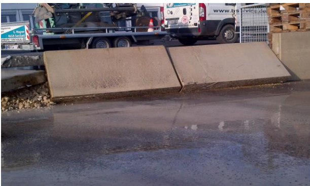
L- Steine mit Asphalt bündig abgesägt
