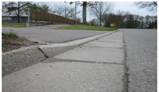
L- Betonbordstein abgesägt
