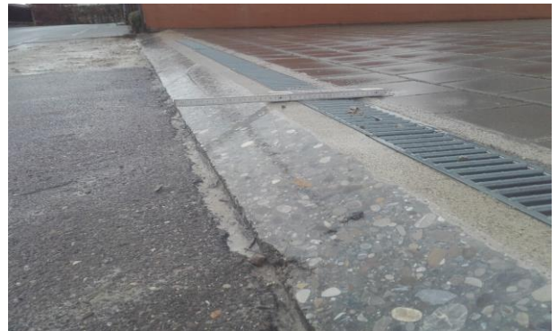
Einfahrt zur Straße abgeschrägt
