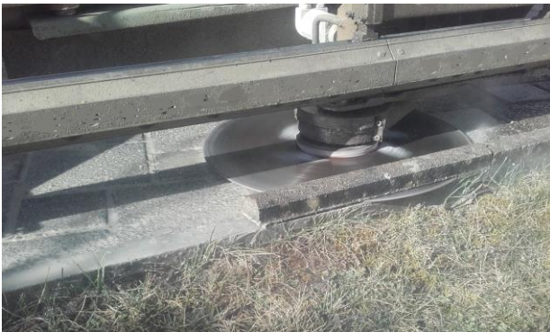
Rasenkantenstein absägen
