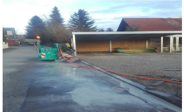
Sägen der Bordsteinabsenkung
